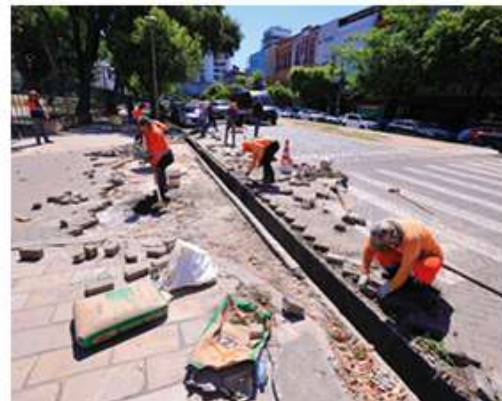
O plano inclui a recuperação de calçadas, sarjetas e faixas
